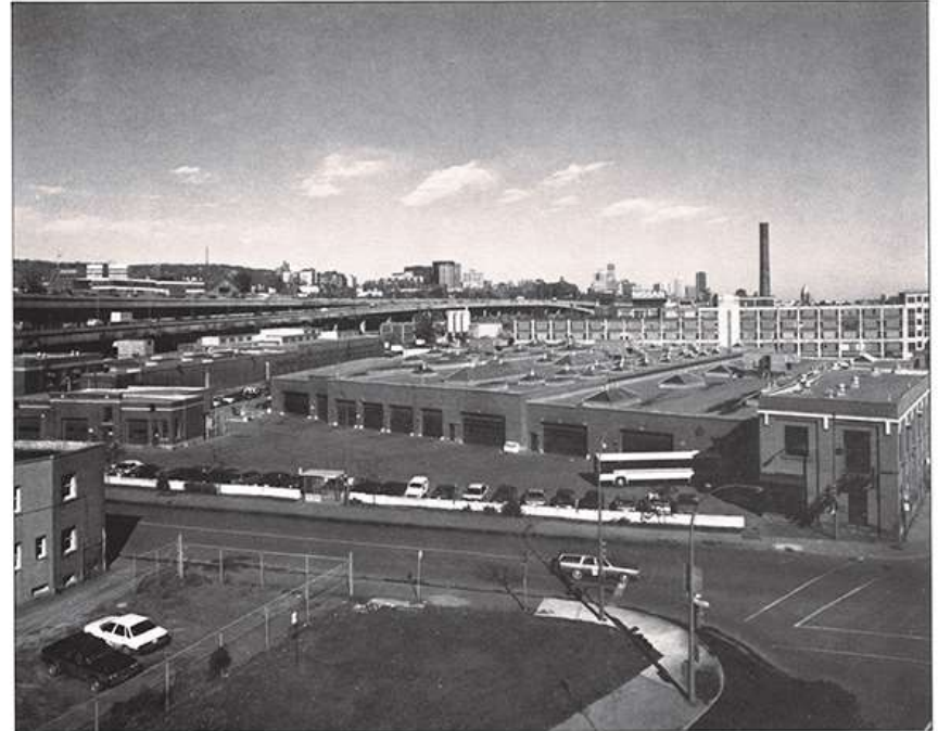
Le Centre de transport Saint-Henri, 4621 ouest, rue Saint-Antoine
